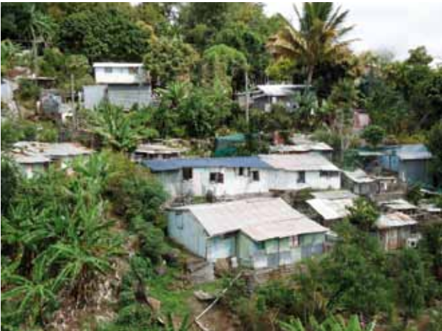
Figure 2. Vue panoramique partielle dudit bidonville, encaissé dans une ravine alimentée par un cours d'eau de façon continue. Un tuyau d'évacuation des eaux usées rejoint ici le cours d'eau.
